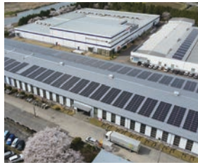
武芸川地区(2023年投入使用)
